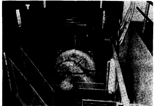
写真1 ポンプ・ステーションの内部の様子
